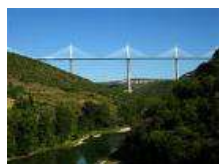
Viaduc de Millau
